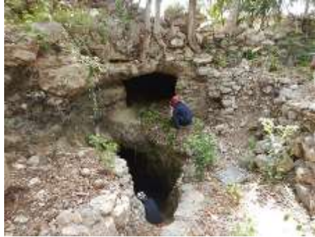
Foto 2 Colapso parcial de muro. Imagen: Addy Loría
